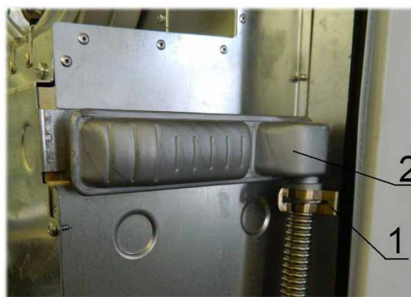
Рис. 23. Демонтаж теплообменника котла «NEVALUX-8230»
