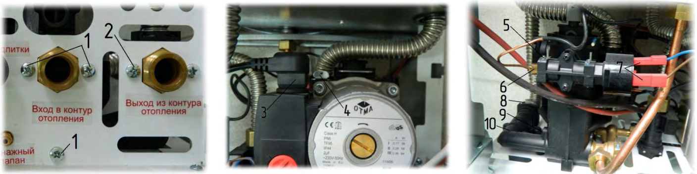
Рис. 17. Демонтаж насоса
