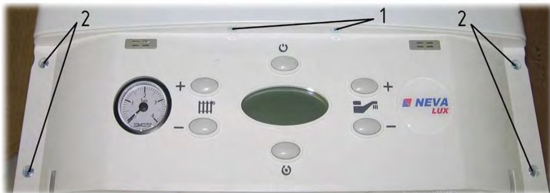
Рис. 13. Демонтаж облицовки и передней панели
