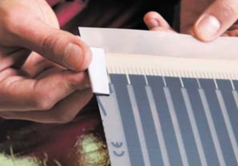
Рис. 12. Окончание процесса изолирования линии отреза медной шины
