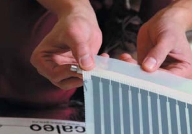
Рис. 6. Установленный на термопленку контактный зажим
