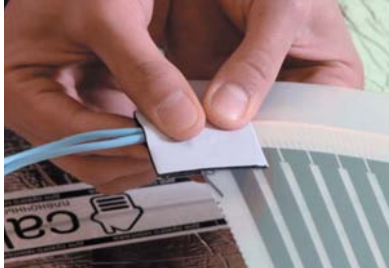
Рис. 18. Установка верхнего листа изоляции
