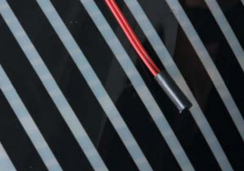
Рис. 21. Установка датчика температуры пола SF 4x15
