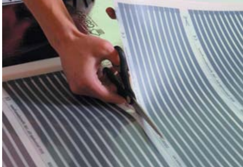
Рис. 5. Разрезание термопленки CALEO по линиям отреза
