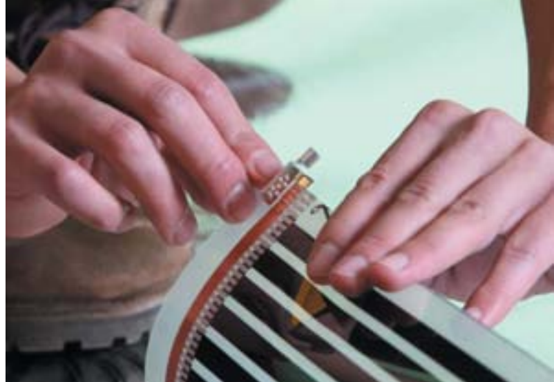
Рис. 7. Установленный на термопленку контактный зажим со стороны медной полосы (снизу)
