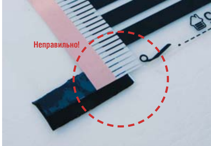
Рис. 11. Пример неправильной установки изоляции линии отреза медной шины
