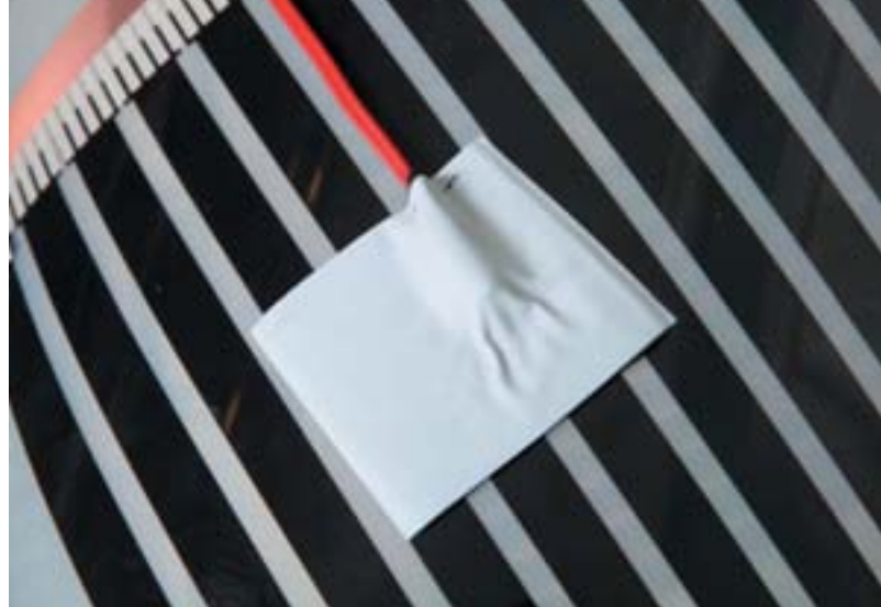
Рис. 24. Установленный и приклеенный датчик температуры пола. Вид снизу термолентки
