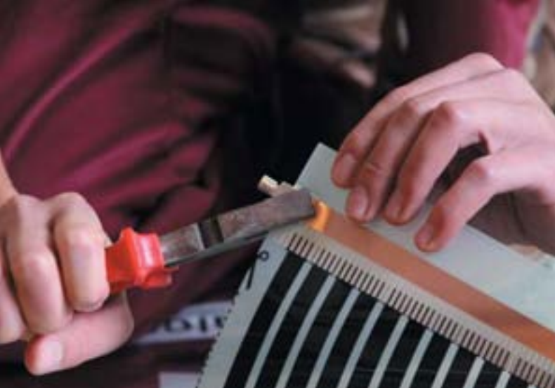
Рис. 8. Крепление контактного зажима к термолентке
