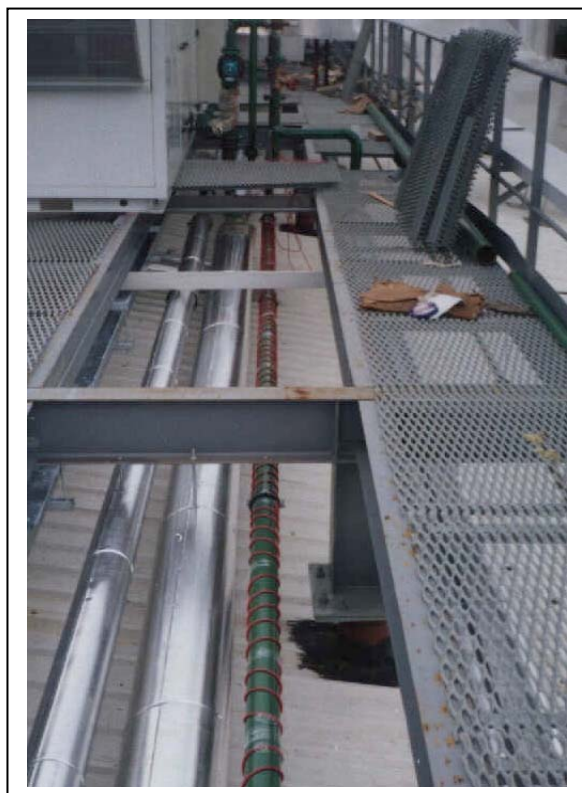
Рис. 4. Монтаж нагревательного кабеля Deviflex™ DSIG-20 на трубопроводе и на крыше.
