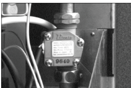
Obr. 12: Plynový ventil, automatika, snímač průtoku na vstupu
