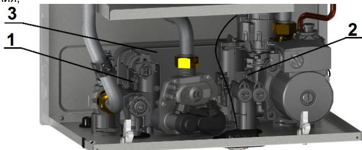
Рис. 14 Демонтаж вторичного теплообменника
