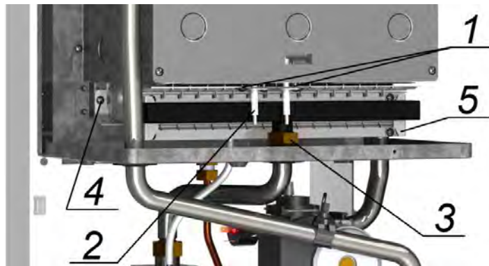
Рис. 16. Демонтаж блока горелочного
