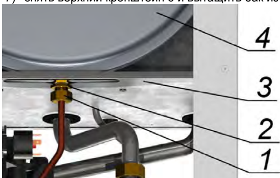
Рис. 20. Демонтаж трубы расширительного бака
